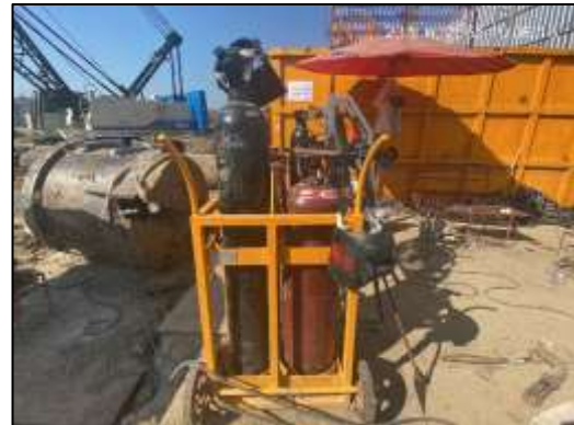
ภาพที่ 38 พื้นที่จัดเก็บเชื้อเพลิงและวัตถุไวไฟพร้อมป้ายเตือนอันตราย
